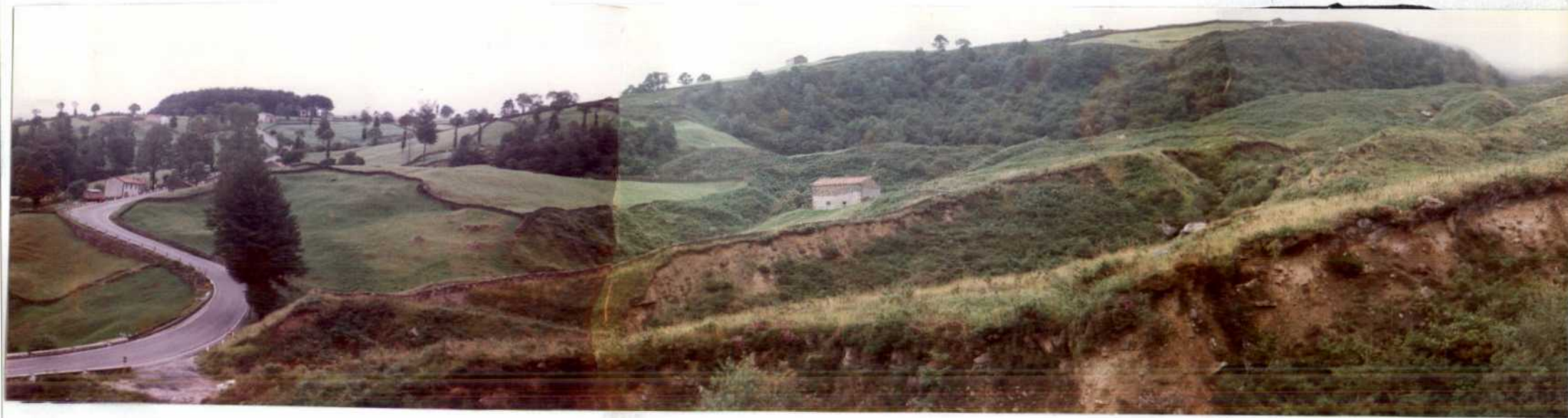
Deslizamientos recientes en el Puerto del Escudo a la altura de arroyo Sonero. La raíz del deslizamiento se corresponde con la zona de arbolado más intenso.
